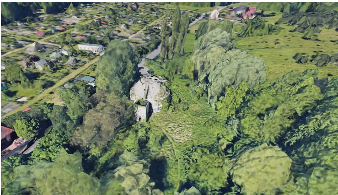
Rys. 2. Widok z lotu ptaka na budynek oczyszczalni Folszowa
